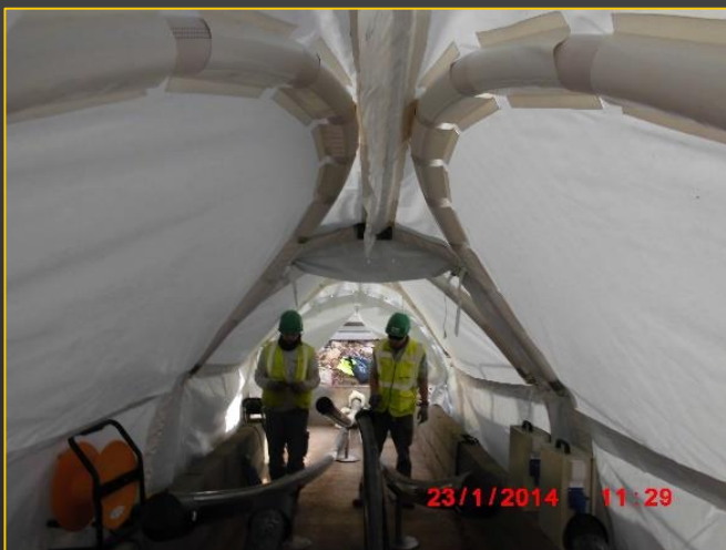
Abri sur chantier de raccordement
