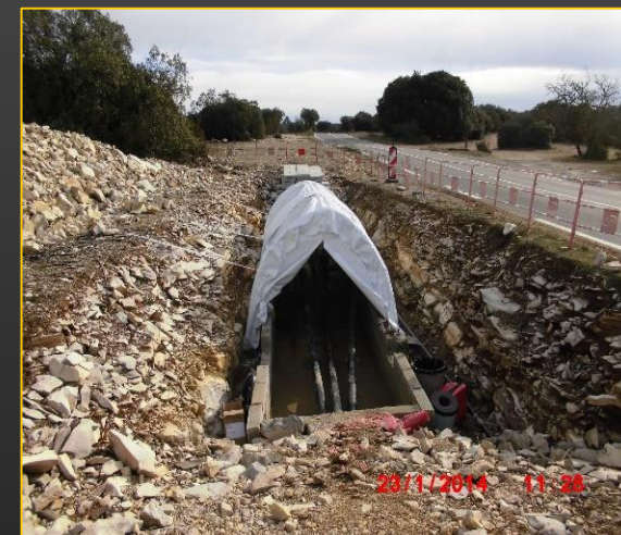
Abri sur chantier de câblage
