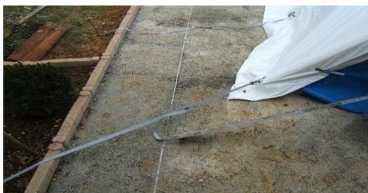
*Sangles déport fixées à 45° sur béton*
