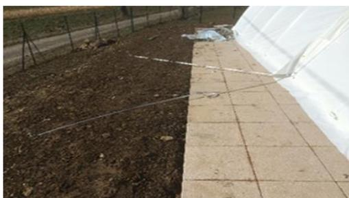
*Sangles déport fixées à 45° au raccord de 2 modules*
