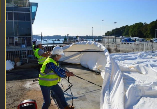
Montage sans engins de levage
