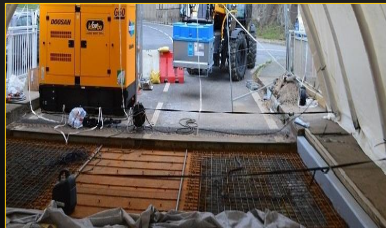
Idéal pour chantiers ferroviaires et routiers
