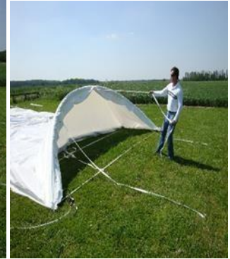
Élévation de la première baleine à 45°
